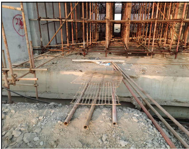
图1 木乃南堤大门口闸段工程上落水闸底板的临时通道搭设不规范。
